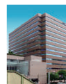
新大阪ブリックビル外観
